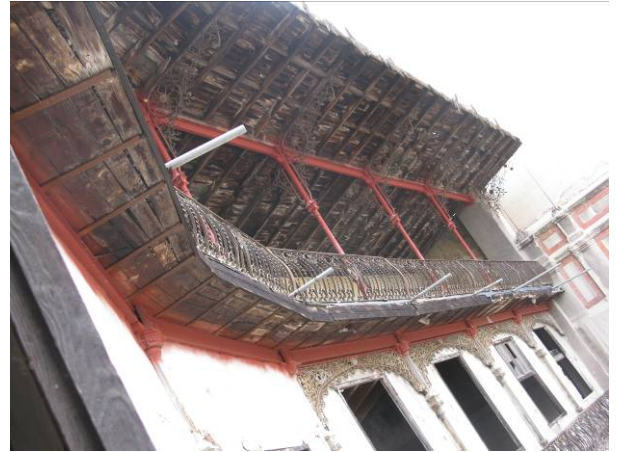
Balcón corrido del graderío alto
