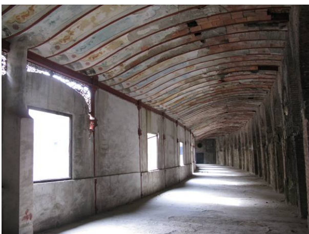
Graderío del tercer piso con el singular forjado curvado y la galería cegada
