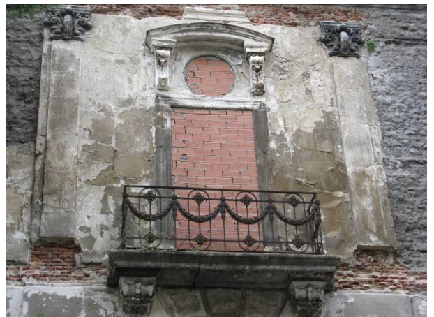
Detalle de los desperfectos causados por el anterior andamiaje
