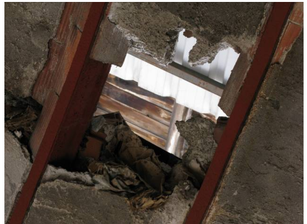
Detalle de los revoltones degradados
