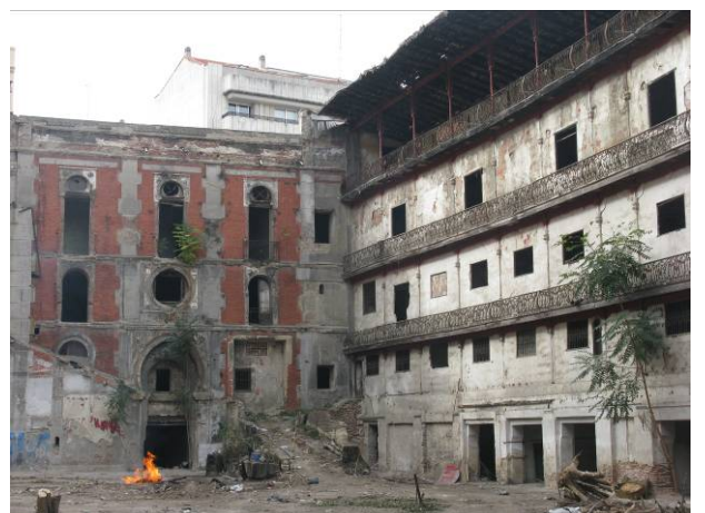
Encuentro de la fachada neomudéjar con el graderío
