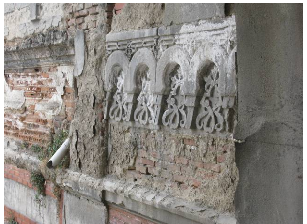
Muestra de la ornamentación original de cornisa parcialmente desaparecida
