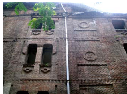
Canalones rotos o desaparecidos y vegetación parásita en los extremos oeste y norte de la torre trasera de escaleras
