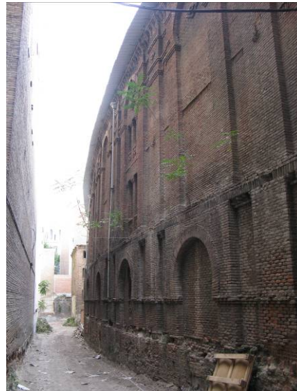
Vista general de la cara oeste con vegetación parásita
