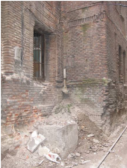
Degradación de la fábrica de ladrillo en el basamento de la cara oeste
