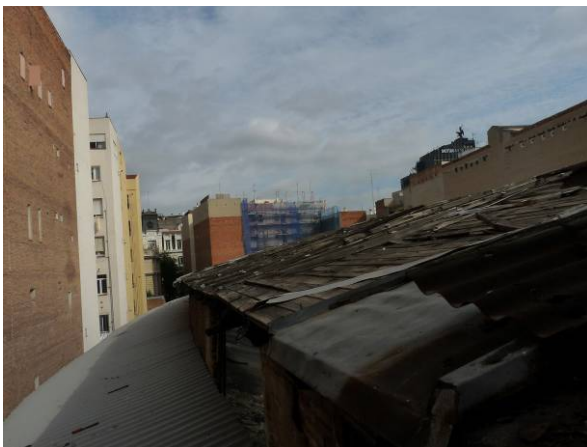
Placas de zinc desaparecidas
