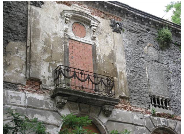
Parcheado con cemento de los revocos originales
