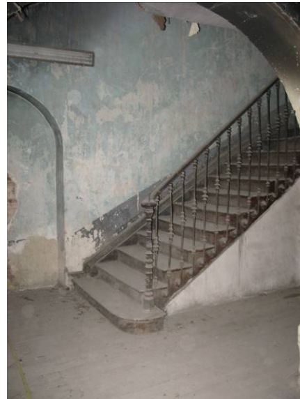
Arranque de la escalera principal
