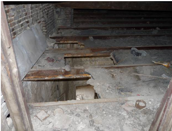
Forjado del tercer piso del edificio principal
