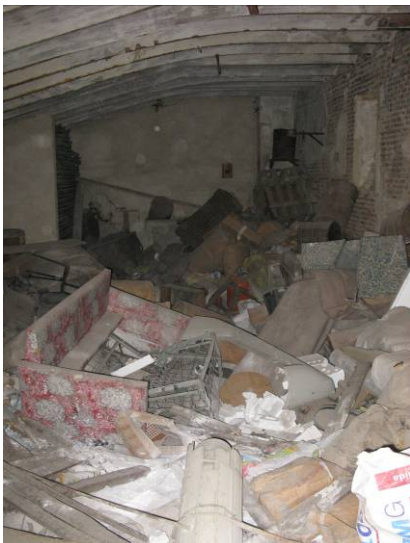
Acumulación de escombros bajo la grada inferior
