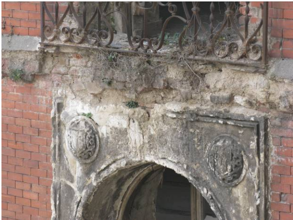
Desprendimiento de molduras de impostas
