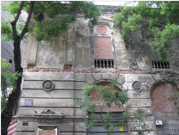
Extremo occidental de la fachada principal
