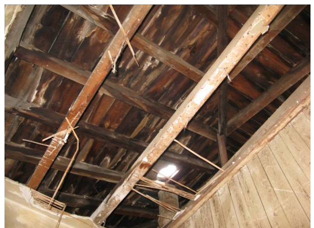
Cubierta del torreón con el cielorraso desprendido
