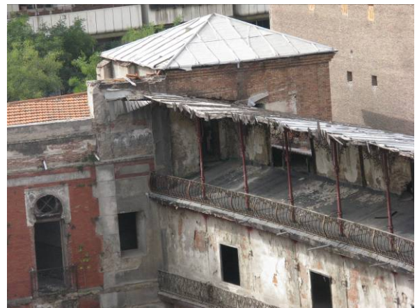
Vista del extremo sur
