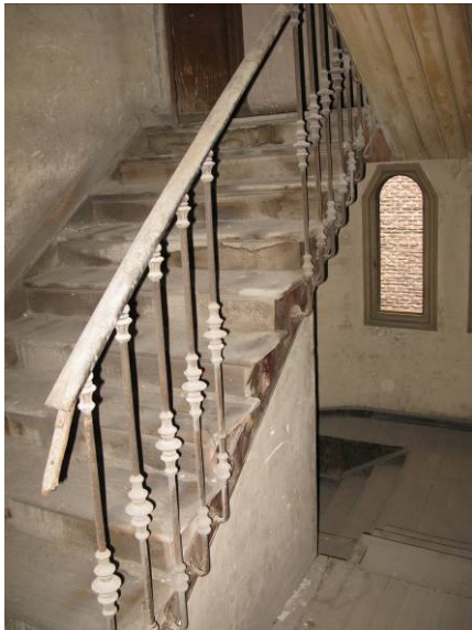
Balaustres desaparecidos en barandilla de escalera principal
