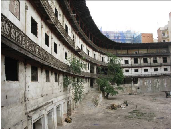
Vista general del graderío tapiado
